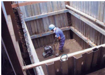
浄化槽設置工事(排水ポンプ付) (W2,640×L5,180×H2,100)
