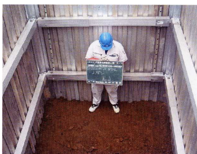
浄化槽設置工事(排水ポンプ付) (W2,640×L5,180×H2,100)
